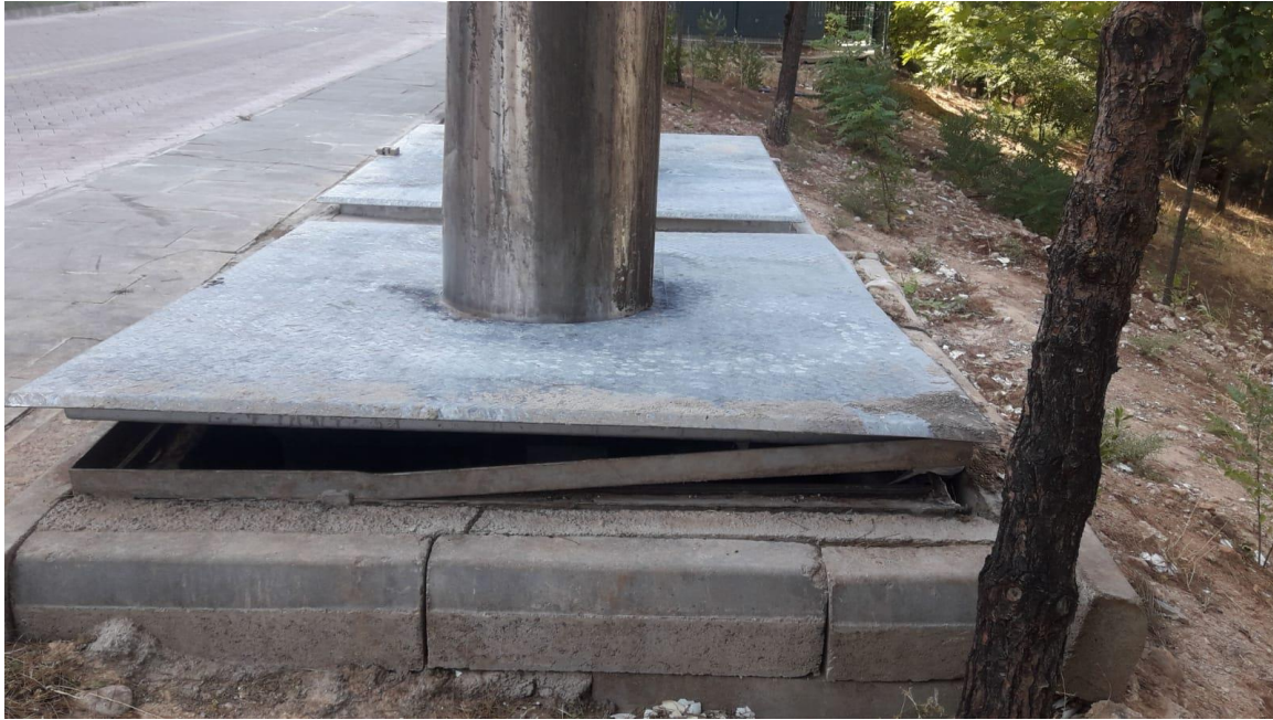
7-Sosyal Kültürel Merkez Binası yemekhane tarafında bulunan yer altı çöp konteynerine piston alınması
